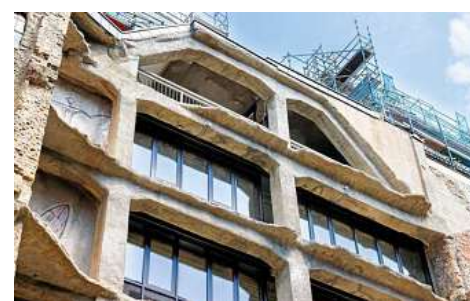
Blick auf die Fotografiska-Fassade.
