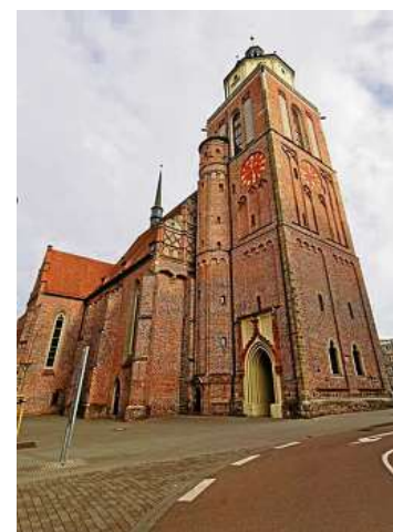
1998 wurde der Wiederaufbau der Marienkirche fertiggestellt.
